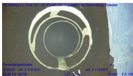
Reprofilierung vor Linereinbau, Quelle: SKT / Hermes Technologie GmbH & Co. KG
